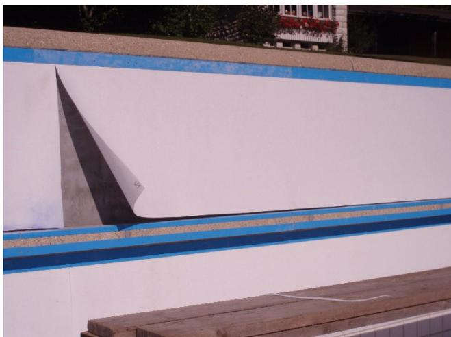
*Aufbau Folie: Flies mit kaschierten Blechen zur Befestigung der Folie*
